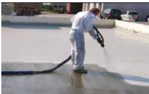
شکل ۲- نمونه‌ای از اجرای ماده غشاساز
